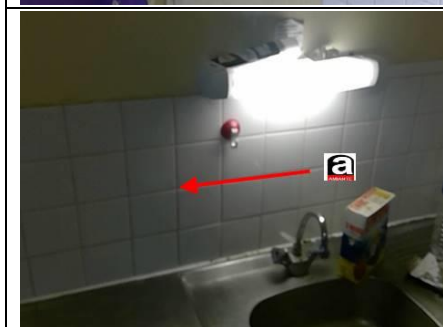
Photo n° PhA002 Localisation : 2 - Cuisine Ouvrage : 3 - Parois verticales intérieures - Revêtements de murs, poteaux, cloisons, gaines, coffres Partie d'ouvrage : Colle de faïence Description : Colle de faïence
