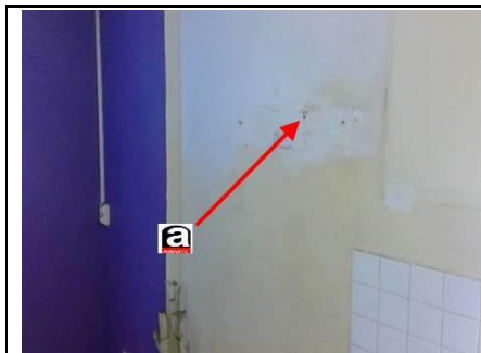
Photo n° PhA001 Localisation : WC; Salle de bains; 2 - Cuisine Ouvrage : 3 - Parois verticales intérieures - Murs et cloisons maçonnés Partie d'ouvrage : Enduit à base de plâtre projeté Description : Enduit à base de plâtre projeté
